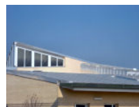
Fig. 15 Particolare lucernario della copertura
