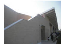
Fig. 6 Prospetto Nord con scala di accesso alla copertura
