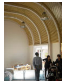
Fig. 3 Particolare della copertura interna in legno lamellare
