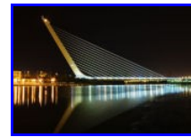
Fig. 1 CALATRAVA, Puente Alamillo, Siviglia Foto di Andrew Dunn © scattata il 7 May 2006
