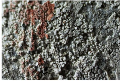
Fig. 8 - Micro-fratturazioni della preparazione a calce
