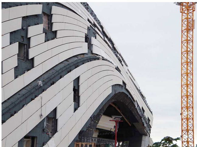
Fig. 7 - ZAHA HADID, Grand Théâtre di Rabat foto della facciata in costruzione, 2014-2021, Rabat. (Incide) Cortesia di Elena Barbonetti
