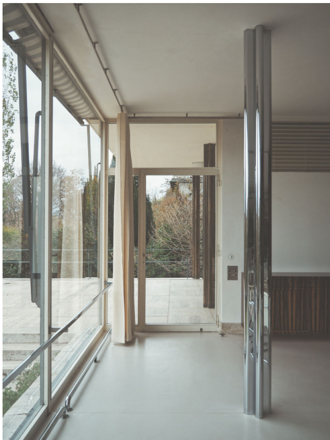
Fig. 2 - Ludwig Mies van der Rohe, Villa Tugendhat uno dei pilastri cromati dello scheletro metallico visibile nella sala da pranzo Foto cortesia di Emilio Zanzi
